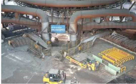
당진 현대제철 고로공장 제논등(450W) 설치
