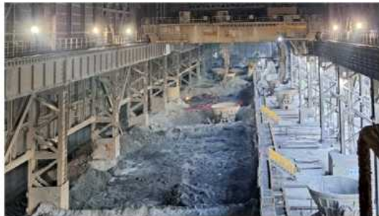
인천 현대제철 슬러지공장 제논등(150W) 설치
